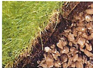
コンクリートへの西洋芝の植栽
